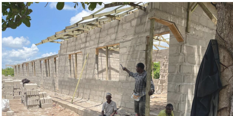
Weil die Grundschule Kiparang'anda aus allen Nähten platzt, wird eine zusätzlich in Finzi gebaut.
