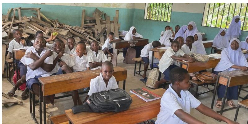
In der Grundschule Kibululu musste das Dach erneuert werden. Es hatte faustgroße Löcher, Unterricht war zeitweise unmöglich.
