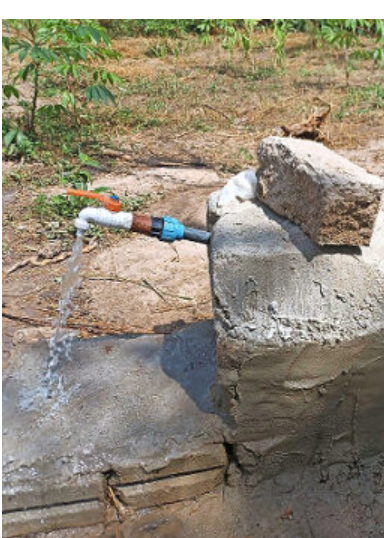
Die neue Wasserleitung hat gleich mehrere Vorteile.
