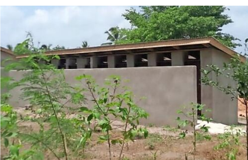
Neue Toiletten in Tumaini: Wegen des Wechselkurses konnten leider nur zehn statt zwölf errichtet werden.
