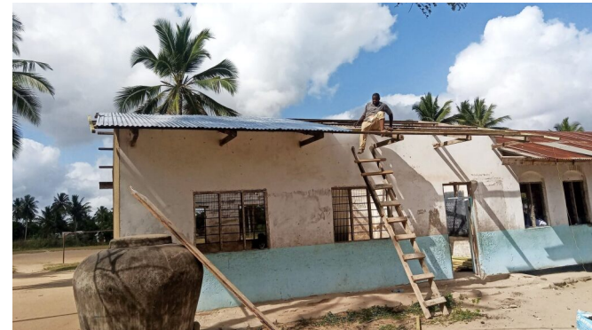
Arbeiten an der Kiparang'anda Schule
