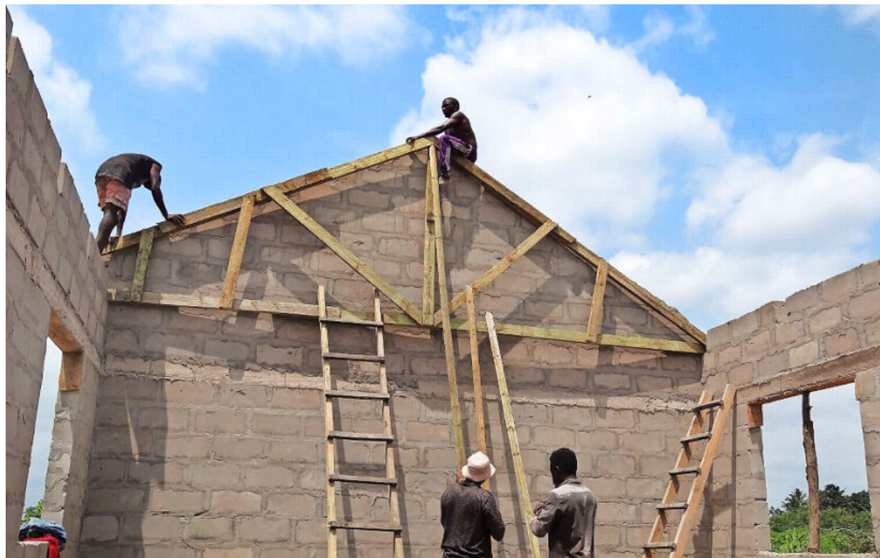
In Magoza wird eine Secondary School gebaut.
