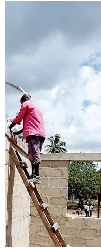
Die Bauarbeiten gehen voran.
