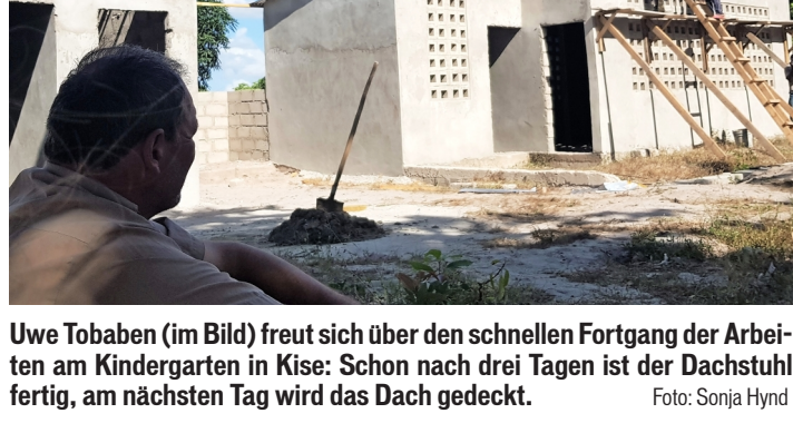
Uwe Tobaben (im Bild) freut sich über den schnellen Fortgang der Arbeiten am Kindergarten in Kise: Schon nach drei Tagen ist der Dachstuhl fertig, am nächsten Tag wird das Dach gedeckt.
