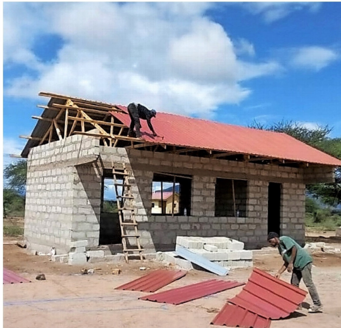
Der Rohbau Longido in Tansania
