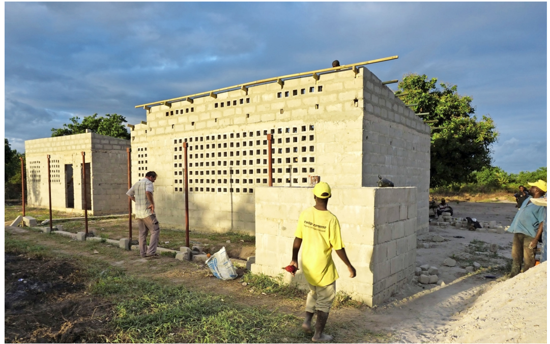
Auch in Kibululu geht der Bau der Schule gut voran.
