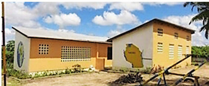
Der Stromanschluss ist für den Kindergarten zu teuer.
