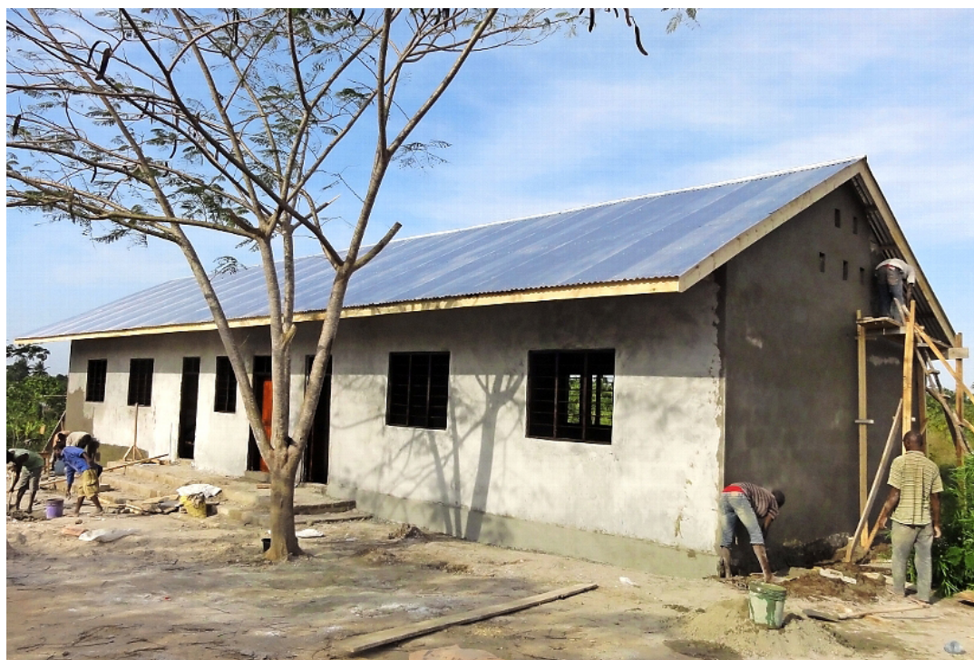
Um ein neues Klassenzimmer für die Grundschule Tumaini in Tansania hat sich die Afrika-Hilfe Hammelburg gekümmert. Foto: Afrika-Hilfe
