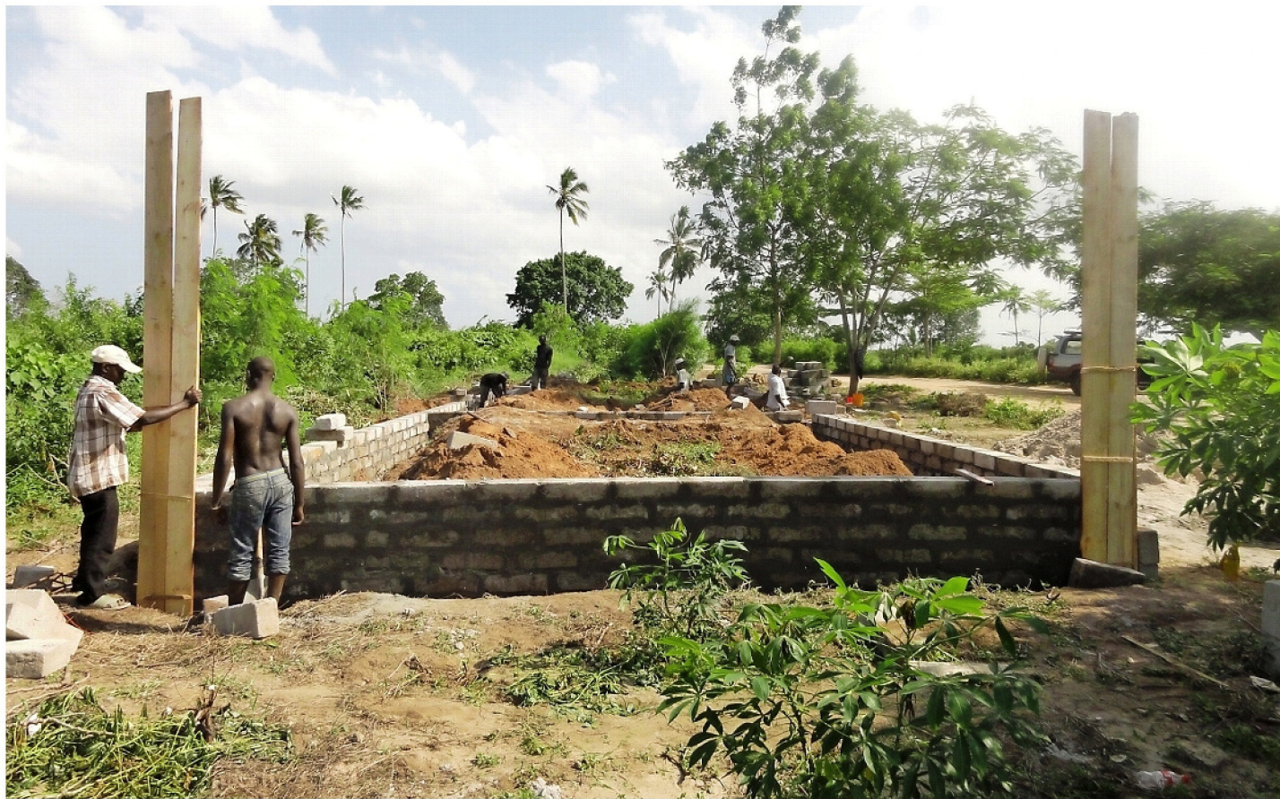
Das Fundament der Grundschule „tumaini“ ist fertig gestellt. Hierauf sollen zwei neue Klassenzimmer entstehen.
