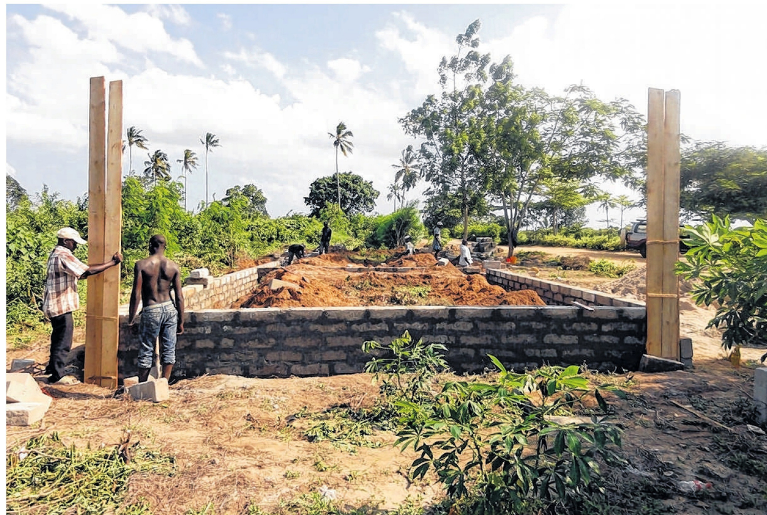
Das Fundament der Grundschule „tumaini“ ist fertig gestellt: Hierauf sollen zwei neue Klassenzimmer entstehen.
